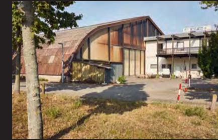
Baulicher Bestand Im Rott/Anna-Sammet-Straße
